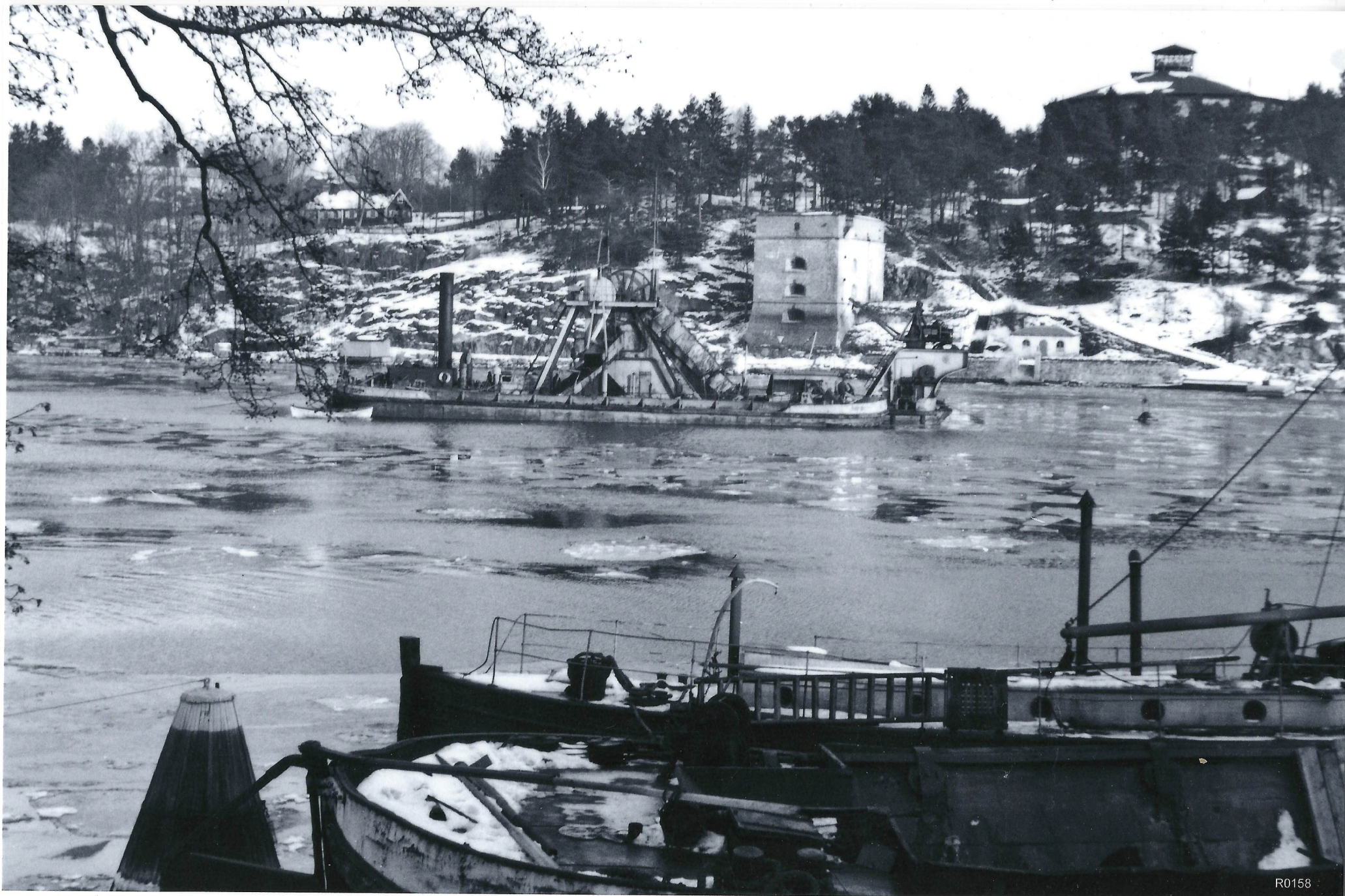
Muddring av Oxdjupet 1928-1930 vilket gav ett djup på 12m och en bredd på 118m Foto: Anders Thunqvist
